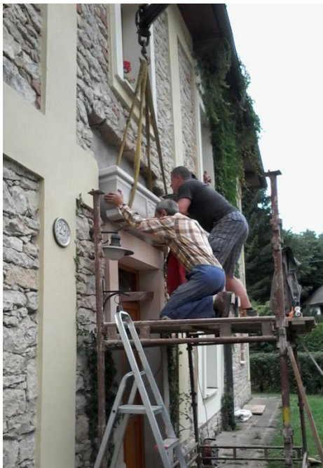
Osazování kamenného portálu
