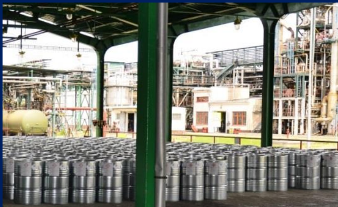
Pohled na sklad a technologii
