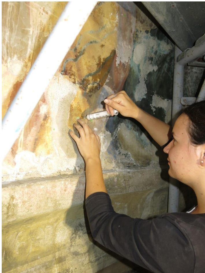
Obr. 9: Postup prací - injektáž místa z obr.7
